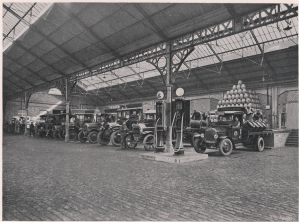
Vue du grand hall
